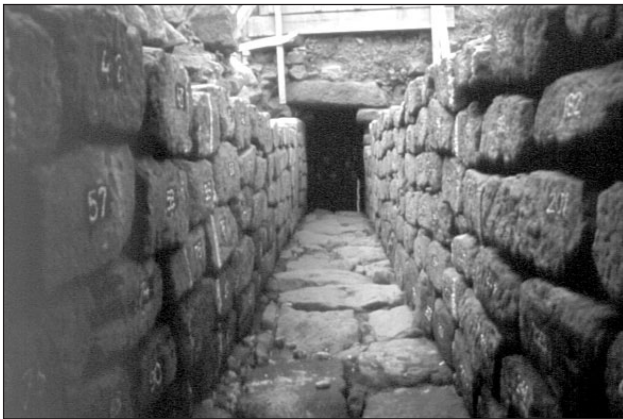
Fig. 5: Interior da cloaca romana encontrada sob rua porticada nas imediações do forum.
